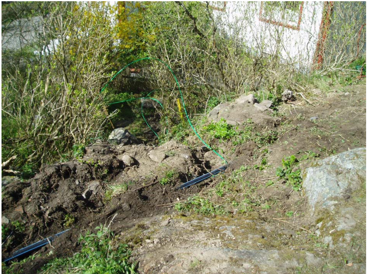
Bild 39. Avstick till 6:4 + 5:6 Skyddsslang ligger mot berg och sen överfyllt med jordmassor.
