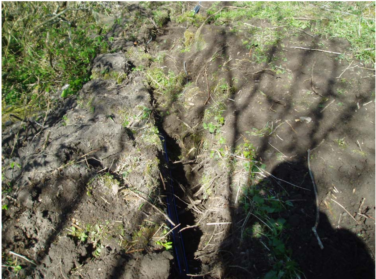
Bild 38. Utanför 6:4+5:6 mot 6:7 tuber ligger i skydds slang+ FK tråd för ut ringning på utsida
