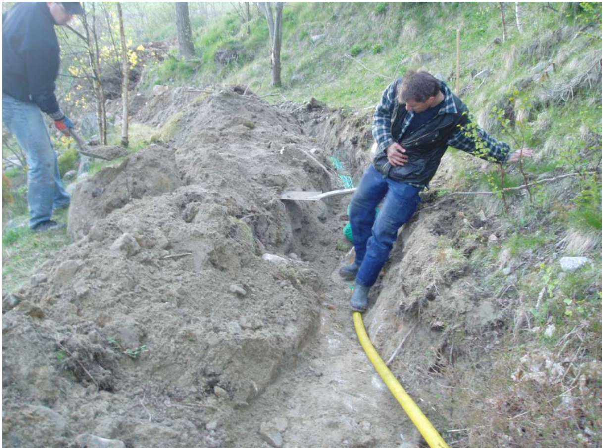
Bild 28. Förbi 6:6 på ovansida hus i väg. Skyddskabel pga vasst berg.
